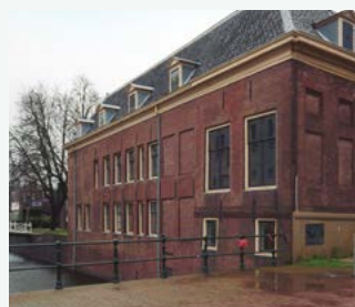
En historisk byggnad vid Marineterrein i Amsterdam. Nederländerna. ECOi-W
